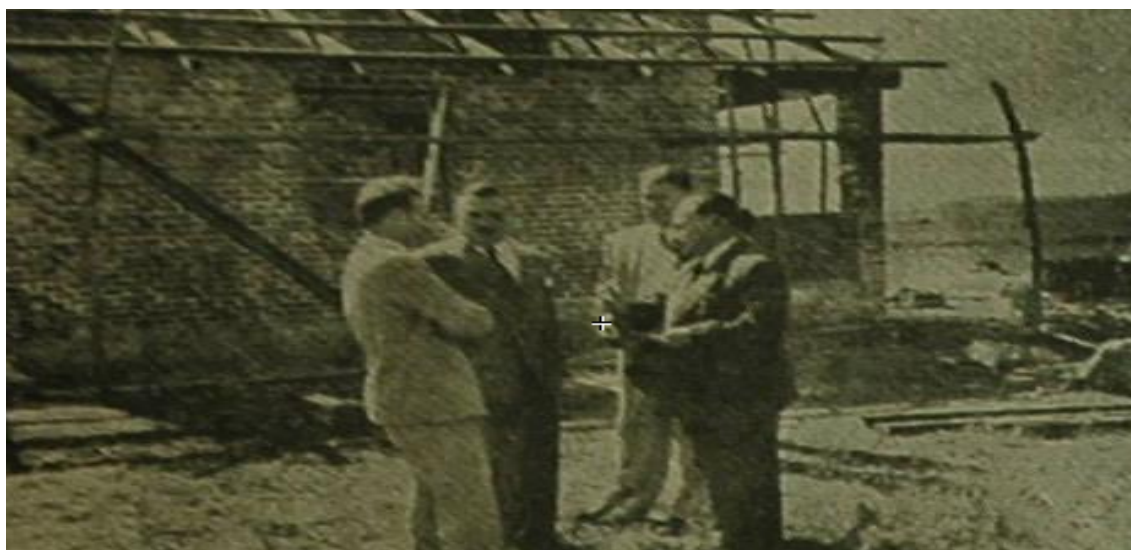
Fotografía 1 Sauce Pinto es próspera y densamente poblada colonia del departamento de Paraná. Sus necesidades escolares serán debidamente atendidas con este edificio en ejecución parte de un plan de 230 construcciones que el gobernador, Dr. Maya, visita Junto con el Ministro de Obras Públicas Ing. Gaggero, vocal del Consejo de Educación, Sr. Lagraña y arquitecto Sr. Massera.
