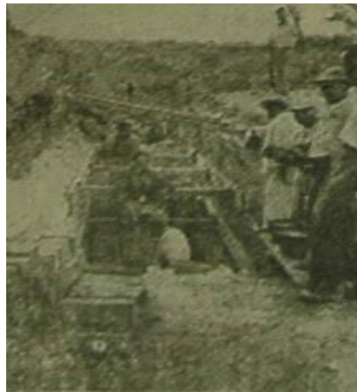
Fotografía 8, 9 y 10: Entubamiento parcial del Arroyo "Antoñico" y de sus cauces de acción, cuya obra permitirá urbanizar las barrancosas adyacencias suburbanas.
