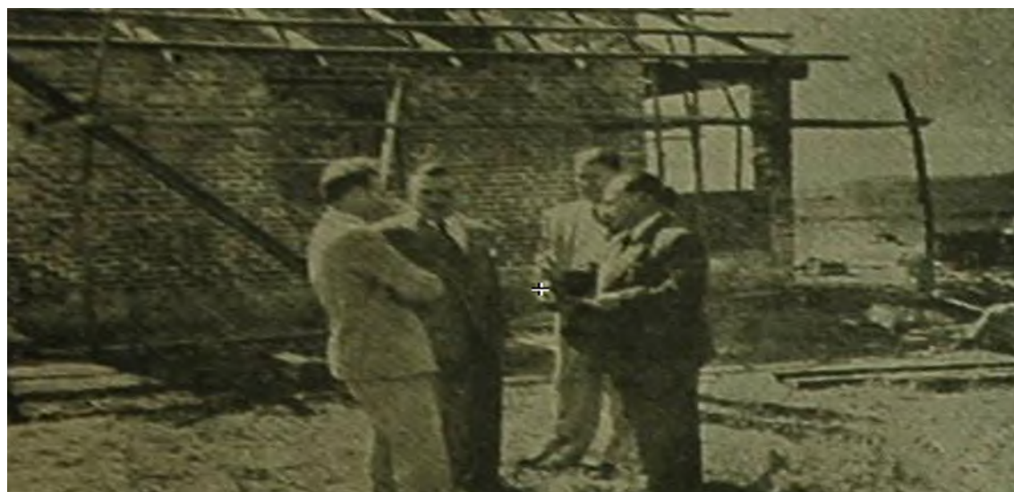
Fotografía 1 Sauce Pinto es próspera y densamente poblada colonia del departamento de Paraná. Sus necesidades escolares serán debidamente atendidas con este edificio en ejecución parte de un plan de 230 construcciones que el gobernador, Dr. Maya, visita Junto con el Ministro de Obras Públicas Ing. Gaggero, vocal del Consejo de Educación, Sr. Lagraña y arquitecto Sr. Massera.
